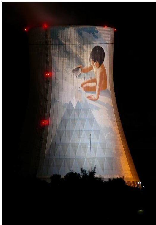
Kyltorn till Cruas-3
